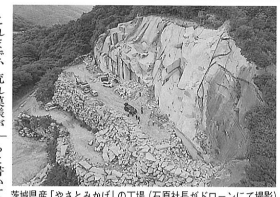
茨城県産「やさとみかげ」の工場(石原社長がドローンにて撮影)
